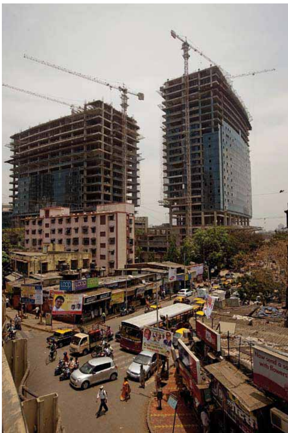
Nye forretningsbygg under oppføring i Mumbai, India. Mens mange snakker om Kinas betydning i dag, vil stadig flere snakke om Indias rolle fremover.
